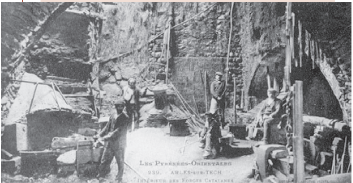
Forge in Arles sur Tech (ARH).
