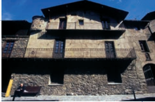
Façade de la maison Areny (AT).
