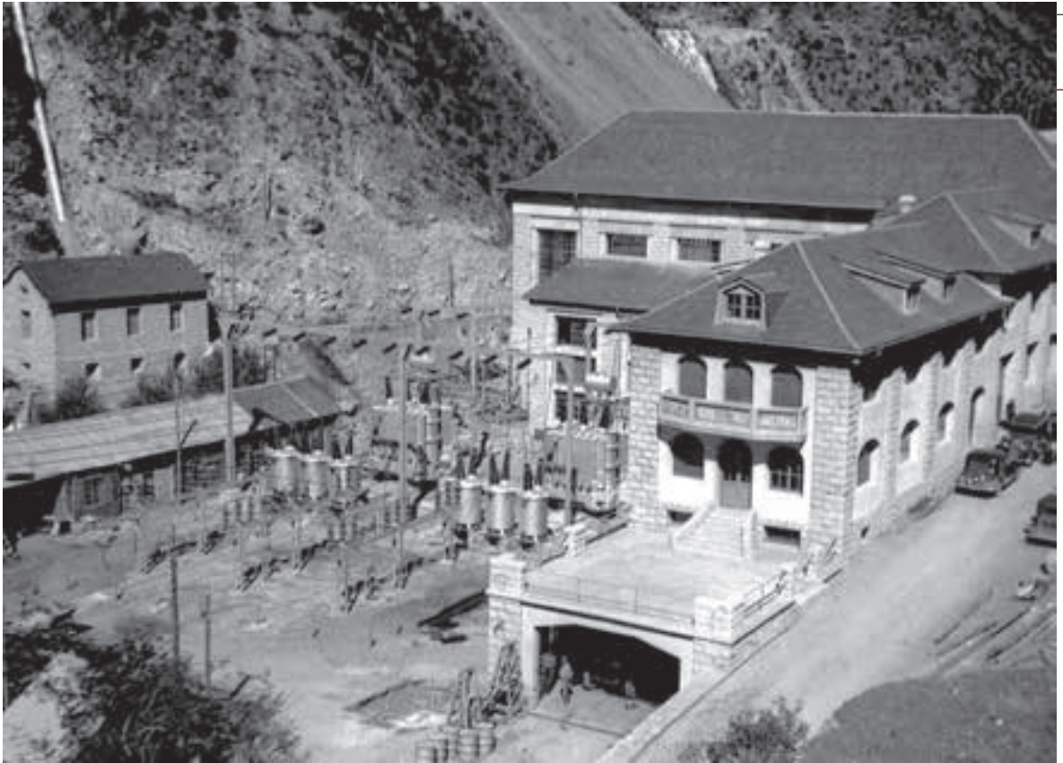
Centrale Hydroélectrique de FEDA (Les Escaldes) (AHN-FEDA, neg. 35).
