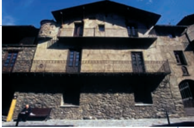
Fachada de la casa Areny (AT).
